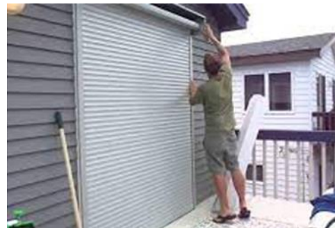
Imagen 3: Protección contra huracán
