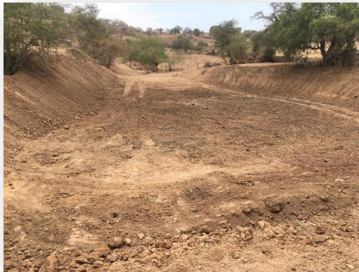
Rehabilitación de bordo abrevadero en la localidad de Xilocintla.
