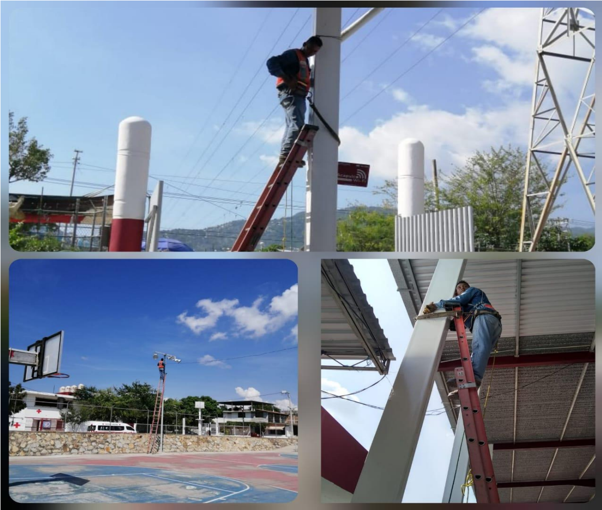
Apoyo con la reparación de luminarias, en las canchas de la colonia ZAPATA el día 02 de diciembre del 2019.
