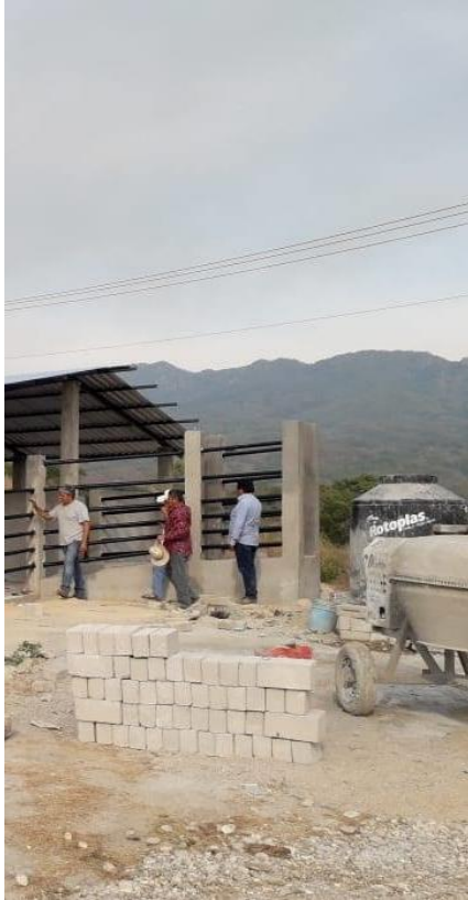
Entrega de material para construcción en la colonia Nueva Esperanza del municipio de Ayutla de los Libres.
