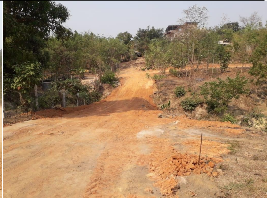
Rastreo de camino del fraccionamiento Los Mangos del municipio de Ayutla de los Libres.
