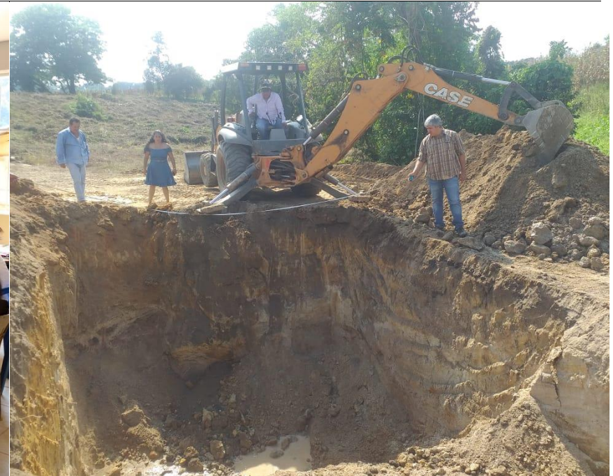
Apoyo con maquinaria para la excavación de fosa séptica en beneficio de la colonia Nueva Esperanza del municipio de Ayutla de los Libres.
