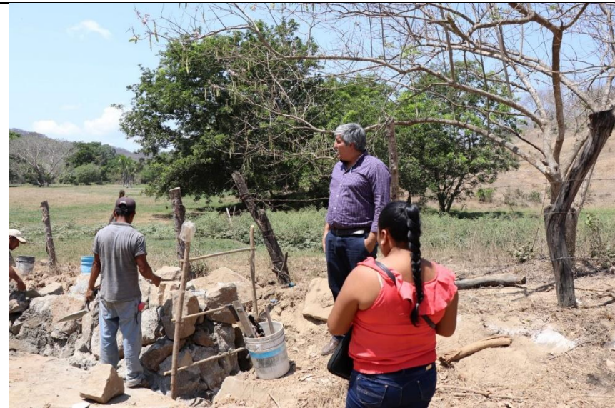
Entrega de material para construcción de muro de contención para la comunidad de El Guinéo del municipio de Ayutla de los Libres.
